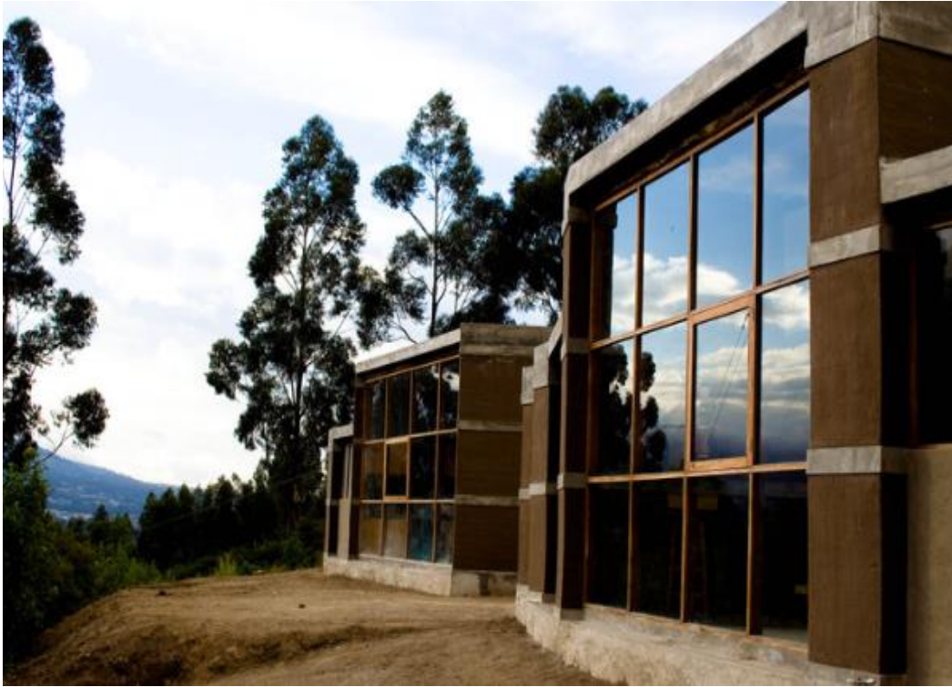
Figura 35. Casa entre muros de al borde
