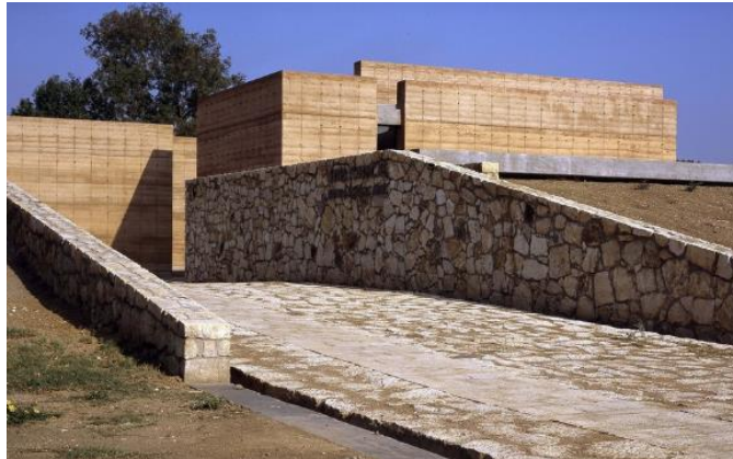
Figura 33. Construcción del taller de artes Visuales
