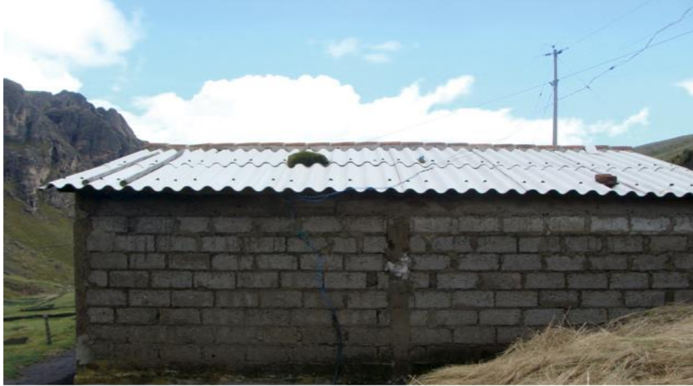
Figura 61. Construcción gubernamental (Propietaria discapacitada)
