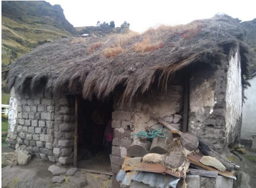
Figura 65. Construcción de adobe
