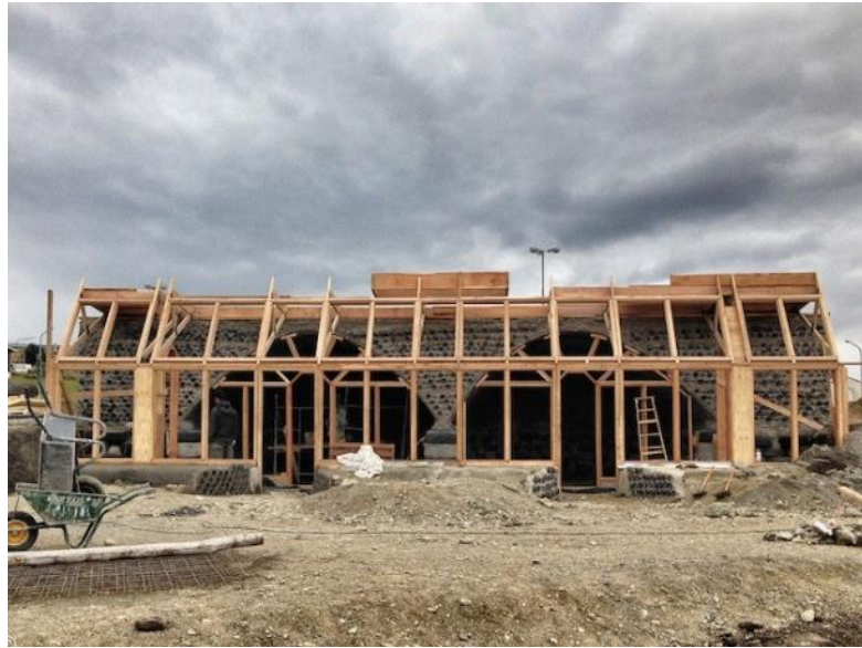
Imagen: Construcción Nave Tierra
