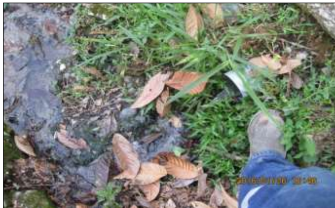
Figura 8. Lugar donde comienza el derrame de aguas grises y negras en la estación Quijos
