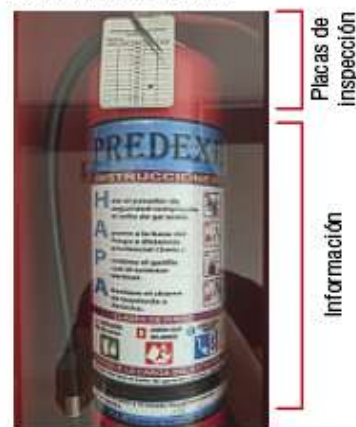
Figura 4. Elementos del extintor.
