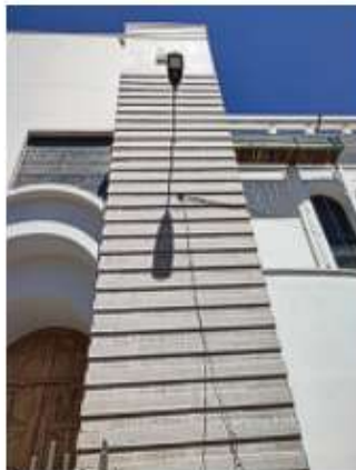
Figura 6. Mantenimiento de la fachada de la Catedral.
