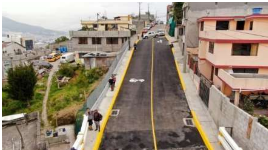
Figura 20: Foto frontal del Puente Triangulo de Piedra de Puengasí
