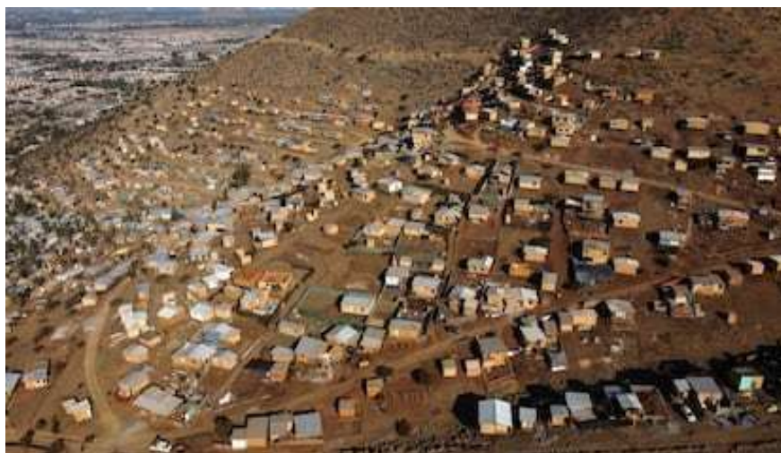
Figura 13. Asentamiento informal en Santiago, Chile
