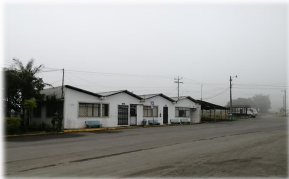
Fotografía 1: Estado actual del camal de Sto Dgo de los Tsáchilas Elaborado Por: Cristian Pinta
