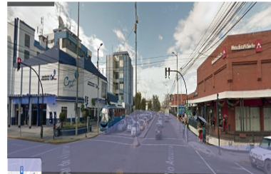
Ancho entre edificaciones
