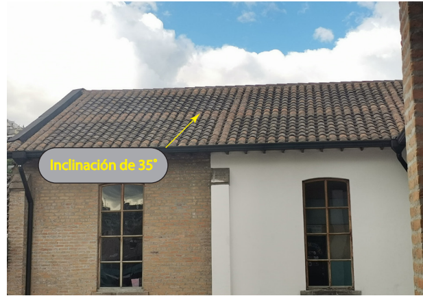
Figura 21. Grado de Inclinación del Centro Popular de Artes y Oficios Fuente: Autoría Propia,2023
