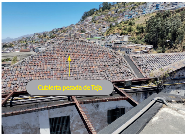
Figura 23. Cubierta del Edificio Administrativo del Ex penal García Moreno
