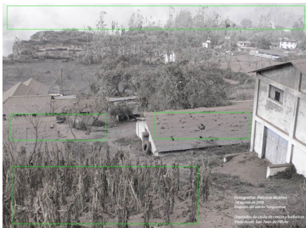
Figura 6. Evidencia de acumulación de ceniza volcánica del volcán Tungurahua en cubiertas, desde San Juan de Pillate
