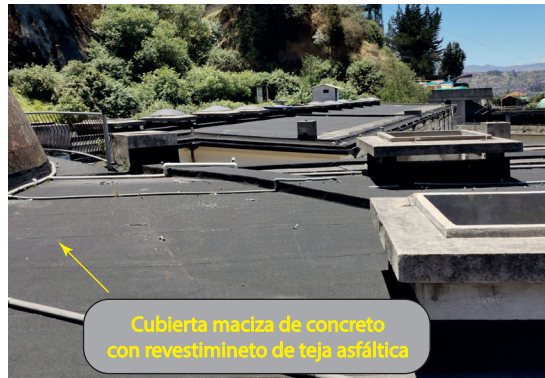
Figura 22. Cubierta del Ex penal García Moreno Fuente: Autoría Propia,2023
