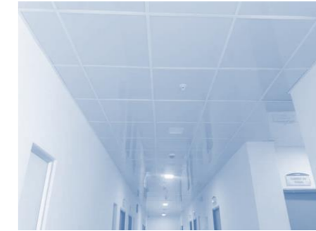
Figura 90 Cielo raso en PVC
