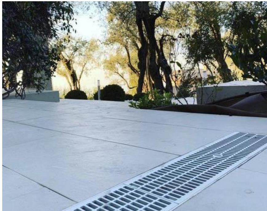
Figura 108 El Canal de drenaje de polipropileno
