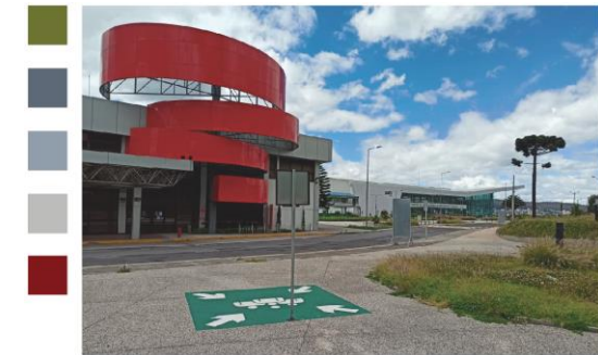
Figura 48 Instalaciones antiguo aeropuerto
