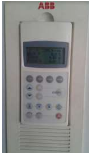
Figura 87: Variador de velocidad ABB
