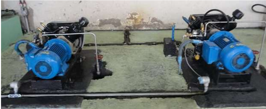
Figura 57: Compresores.
