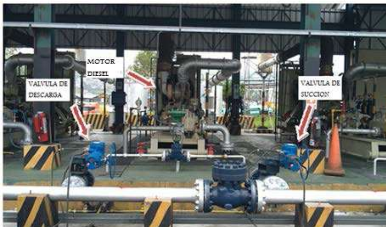
Figura 13: Válvula de succión y de descarga conexión en serie
