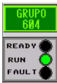
Figura 90: Parámetros de operación-variador de velocidad
