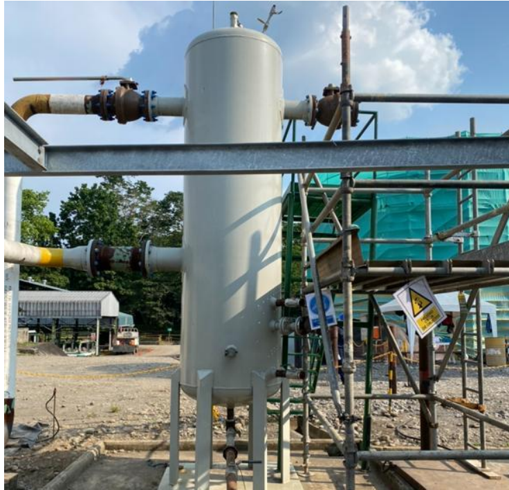
Figura 3. Ubicación de andamios para el desmontaje de accesorios.
