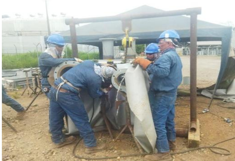
Figura 4. Fabricación de sistemas de izaje improvisados.
