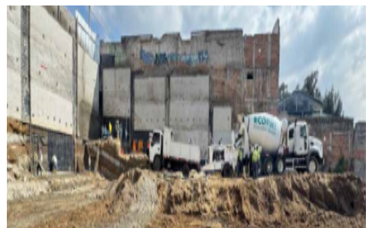
Figura 76. Elaboración de muros pantallas de hormigón armado y anclajes de concreto reforzado.
