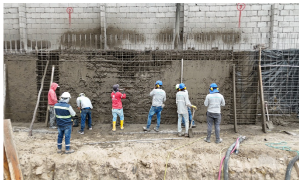
Figura 76. Elaboración de muros pantallas de hormigón armado y anclajes de concreto reforzado.
