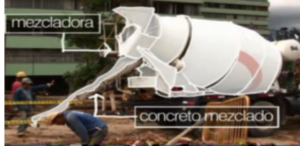
Figura 91. vertido de hormigón de la mezcladora
