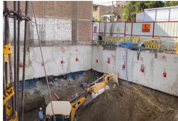
Figura 43. Excavación de tierra con maquinaria.
