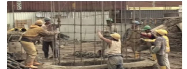
Figura 96. Armado y colocación de la estructura para caisson
