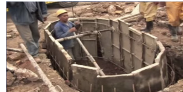
Figura 88. colocación de formaletas.
