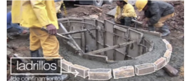
Figura 89. colocación de ladrillos perimetrales.
