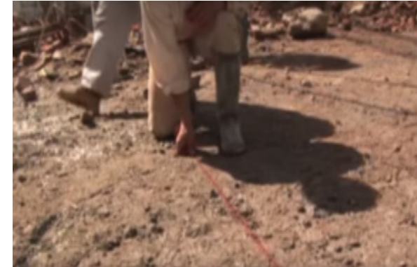
Figura 83. Trazo y replanteo en campo.
