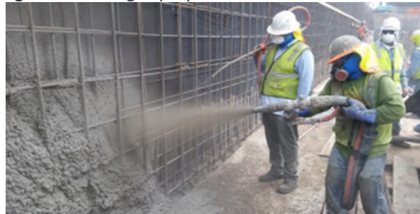
Figura 75. hormigón proyectado.
