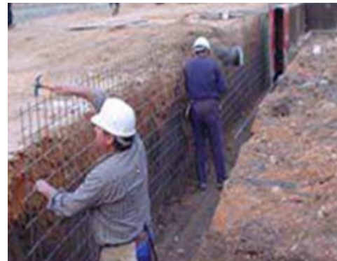
Figura 64. Armado manual.
