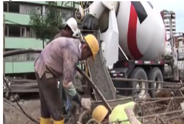
Figura 97. Vaciado de concreto con camión mixer.
