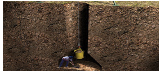
Figura 93. Excavación para ensanchamiento de base de caissons
