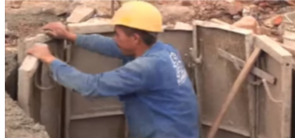
Figura 92. desenfofrado de formaletas.
