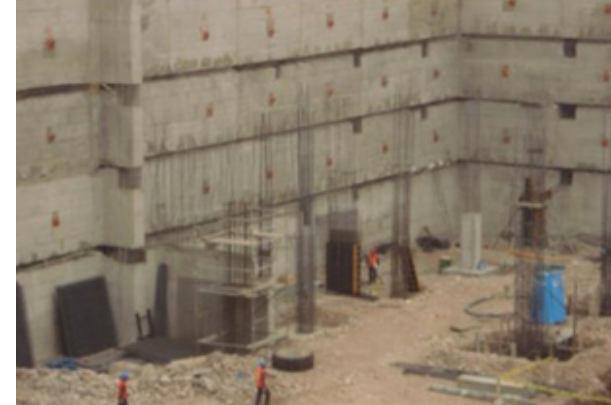
Figura 9. Muro anclado en niveles
