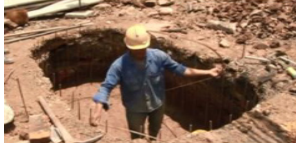
Figura 86. armado de anillos de refuerzo.
