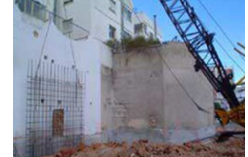
Figura 67. Bajada de la armadura con maquinaria
