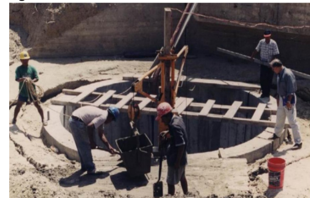
Figura 15. Detalle excavación Caissons.
