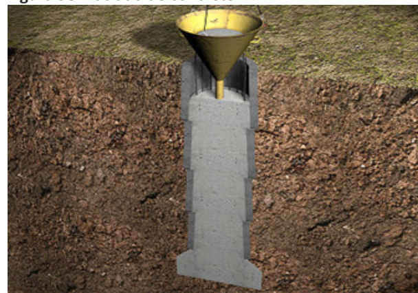
Figura 98. Vaciado de concreto.
