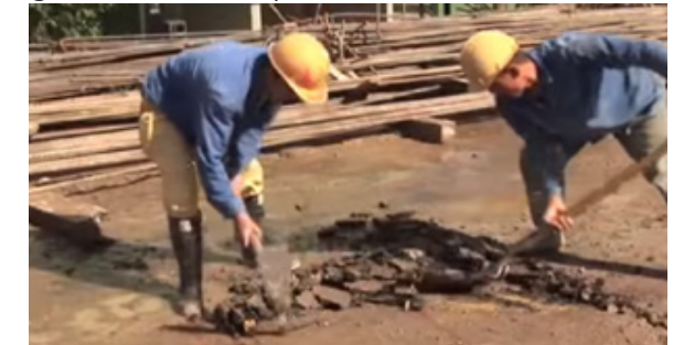
Figura 85. Excavación para los anillos.
