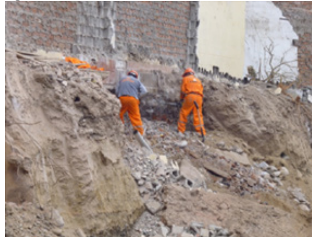
Figura 44. Perfilación de talud manual.
