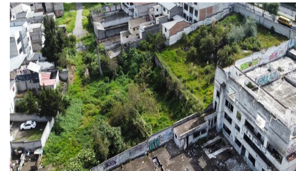
Figura 35. Evidencia de Limpieza del terreno.
