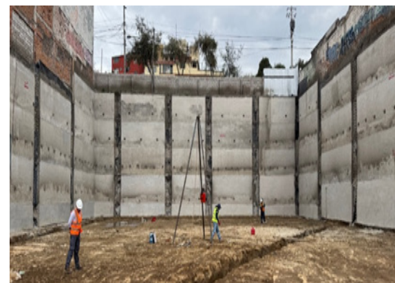
Figura 77. Construcción de muros de hormigón lanzado con anclajes.
