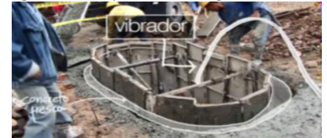
Figura 90. vertido y vibrado de hormigón
