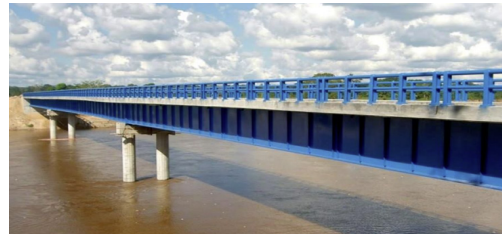
Figura 29. Vistas Puente Yuracyacu.
