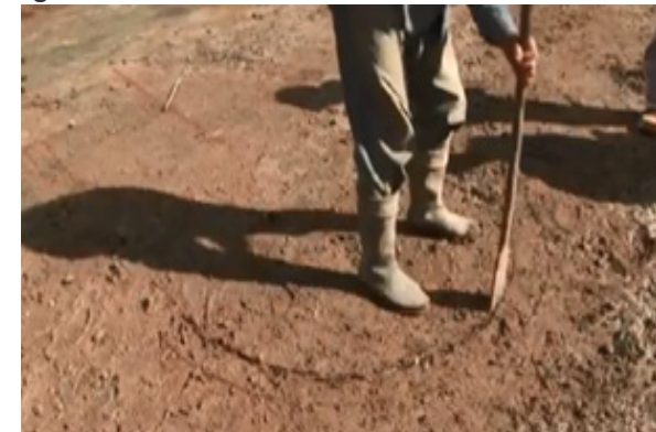
Figura 84. señalización de caisson.
