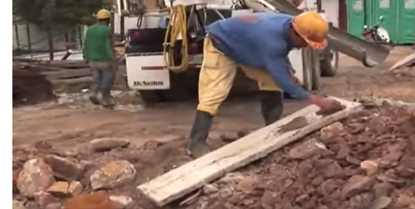
Figura 87. engrasado y colocación de formaletas.
