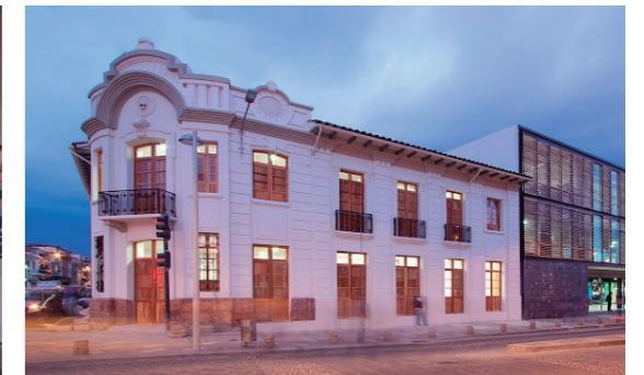
REHABILITACION INTEGRAL DE FACHADAS
