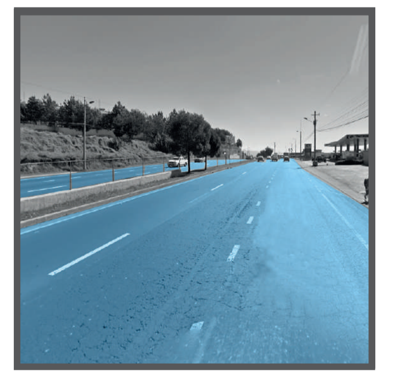
LA AV. SIMON BOLIVAR PERMITIÓ UNA MEJOR Y MÁS RÁPIDA COMUNICACIÓN. DEBIDO A LA FUERTE PENDIENTE NO SE SE PRODUJO LA DENSIFICACIÓN QUE SE ESPERABA
