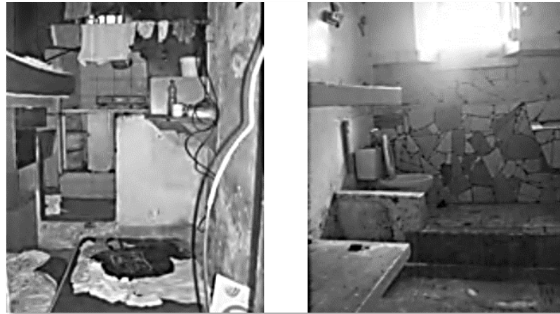
Imagen 32: Vista interior de las celdas Fuente: Gonzales, J. (2010)
