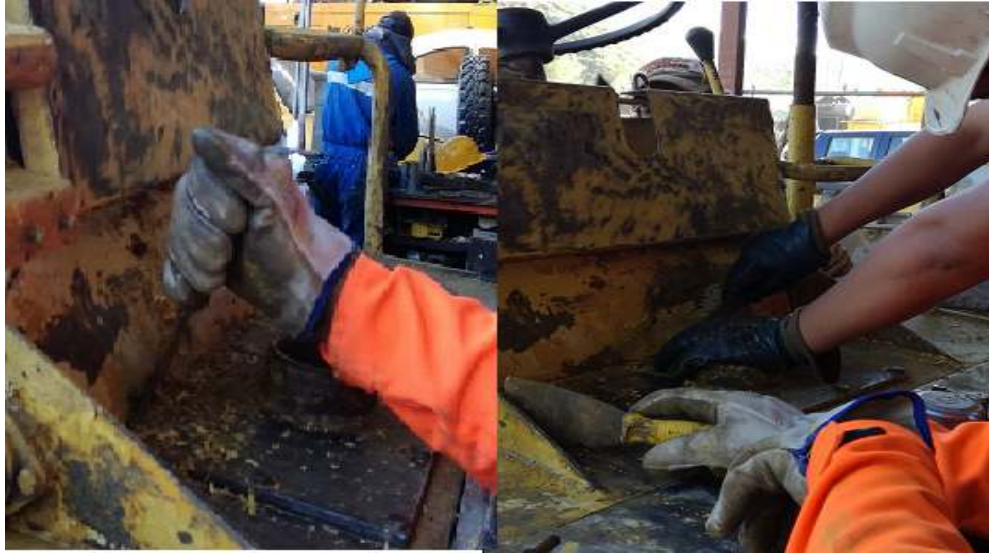
Imagen N° 1: Limpieza manual con cincel y espátula Fuente: JEAL Construcciones
