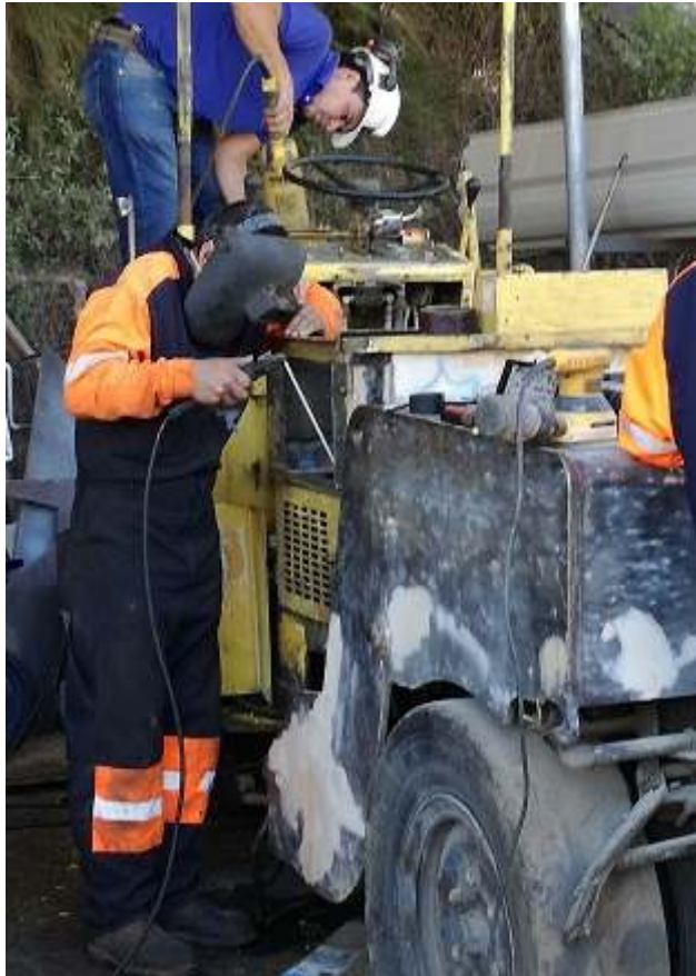
Imagen N° 2: Limpieza con amoladora y soldadura Fuente: JEAL Construcciones
