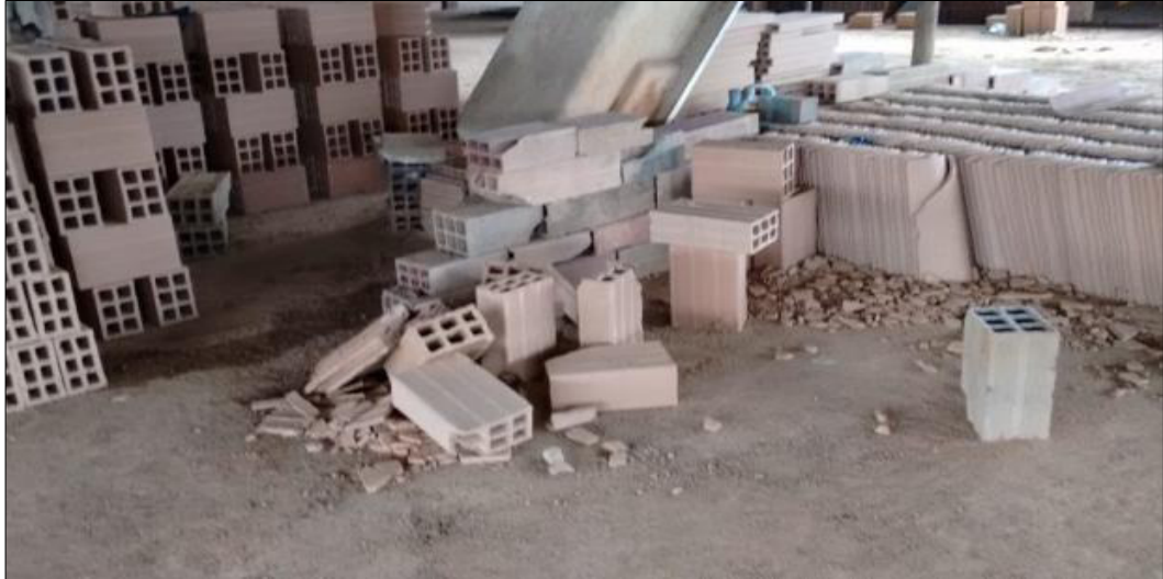
Imagen 17: Ladrillos en mal estado en zona de almacenamiento. Fuente: Chuqui (2019)
