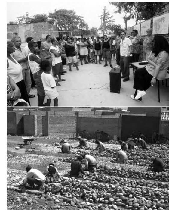
Figura 16. Comunidad participativa en ejecución de obras.
