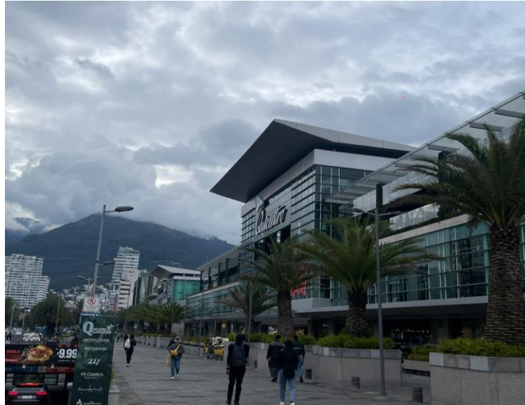
Imagen 13. Fachada exterior del Quicentro Norte
