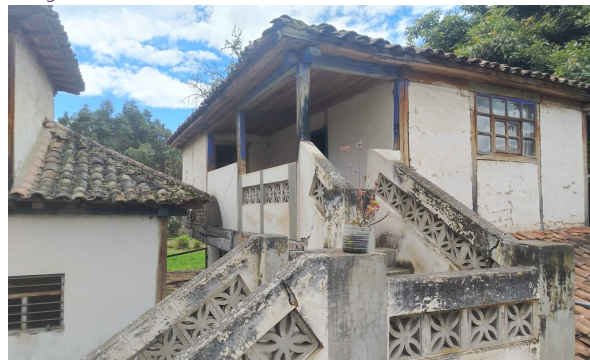
Figura O9. Fotografía 01 vivienda vernácula en estudio.
