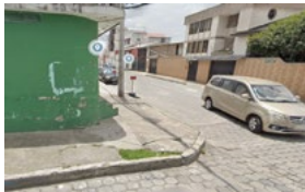
■ Aceras en mal estado
