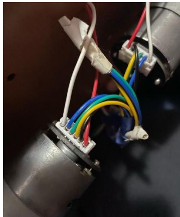
Figura 39 Prueba de funcionamiento de motores.
