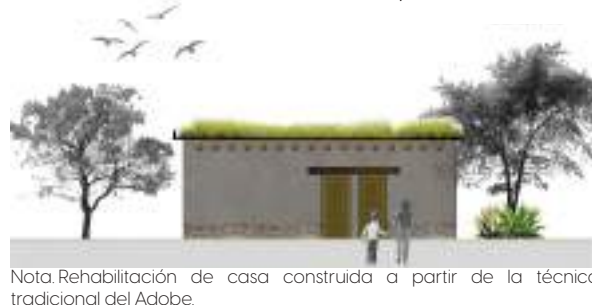
Figura 12. Rehabilitación Casa en San Carlos Yautepec.
