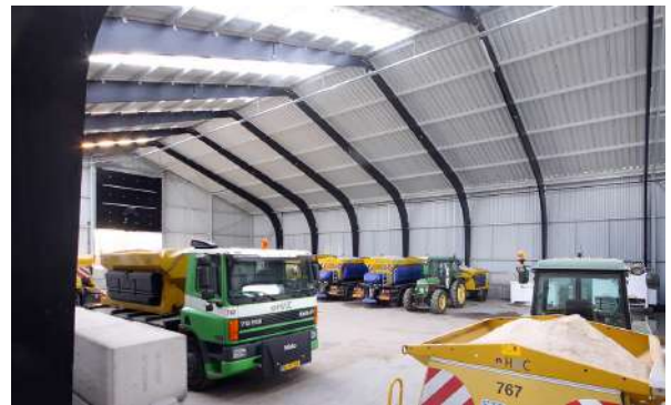
Figura.49. Espacio para maquinaria pesada.
