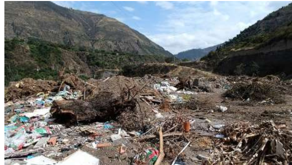
Nota: Estado actual de la escombrera municipal del cantón Patate. Elaboración propia.
