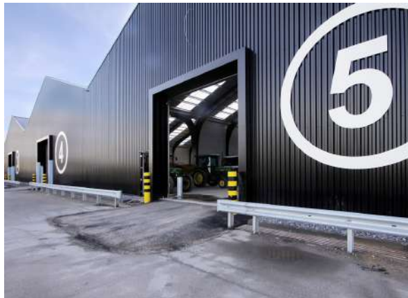
Figura.48. Accesos de maquinaria.
