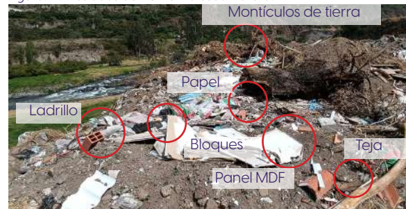
Figura22. Residuos de RCD en la escombrera.
