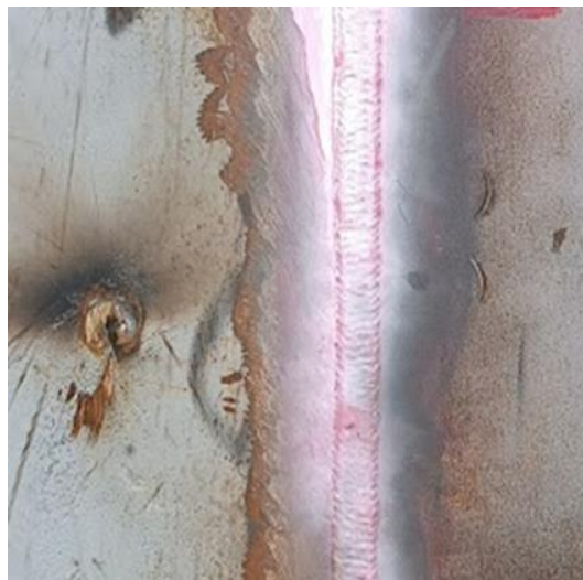
Imagen No. 6: Ensayo con líquidos penetrantes para detectar defectos en soldaduras.
