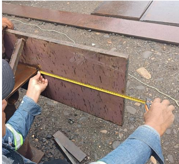
Imagen No. 4 Verificación dimensional de tolerancias conforme a AWS D1.5:2020.
