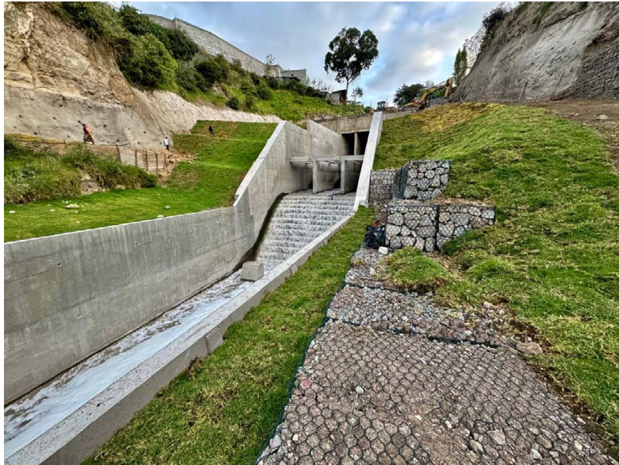
Figura 69. Antes del colector el colegio.
