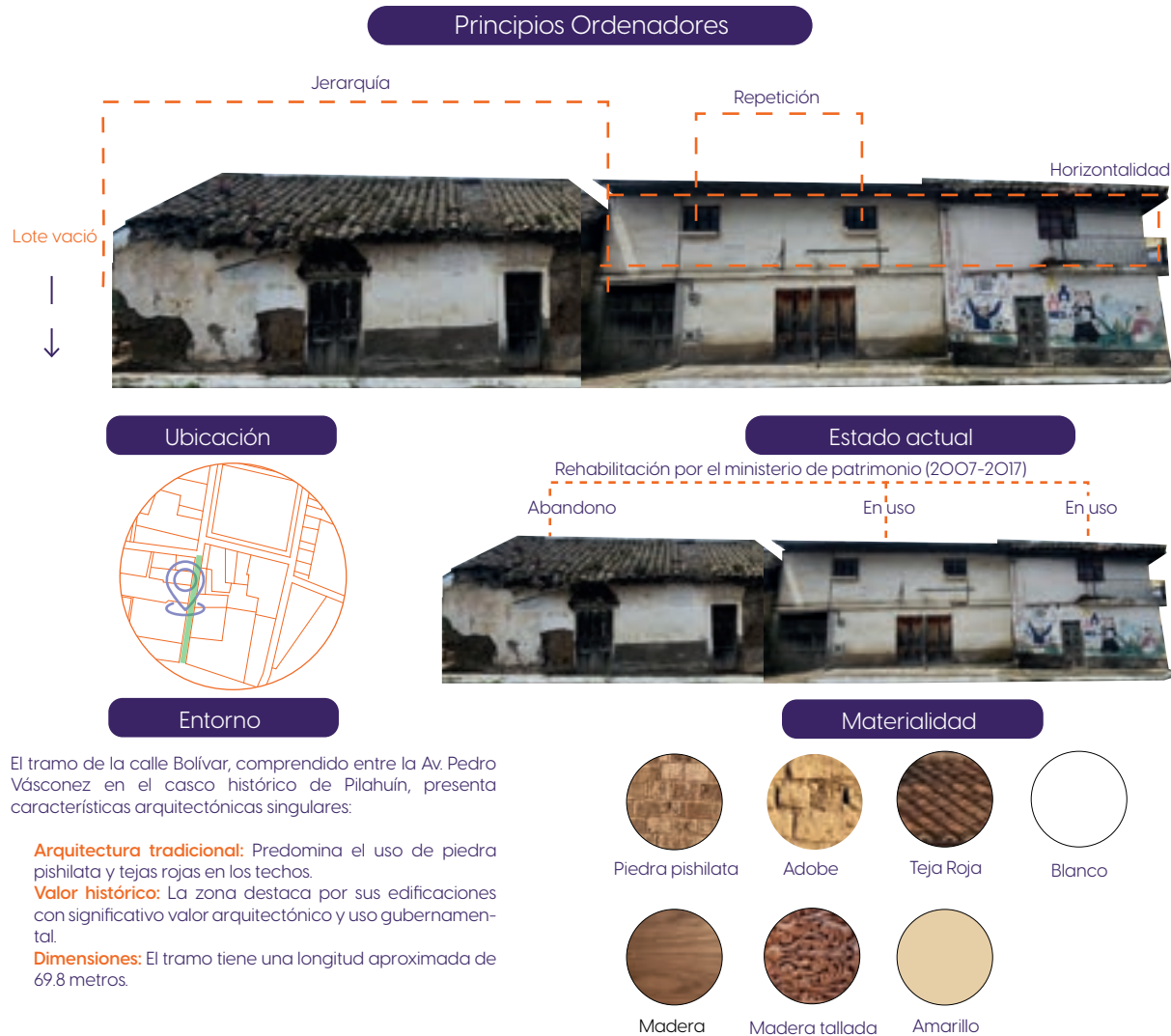
Figura 27. Tramo 8.- fichas de análisis de fachadas y sus elementos identificativos.
