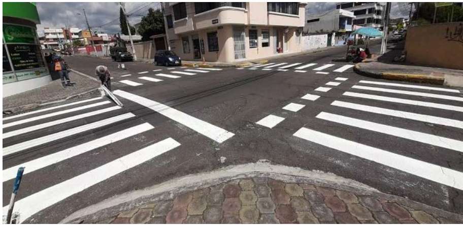
Figura 3. Cruce peatonal señalizado.
