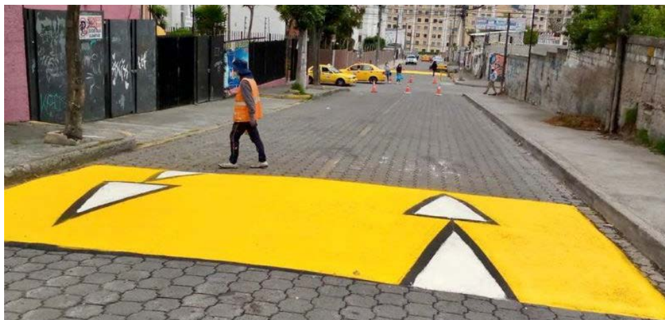
Figura 4. Reductor de velocidad señalado. Fuente: (Quito informa, 2024)
