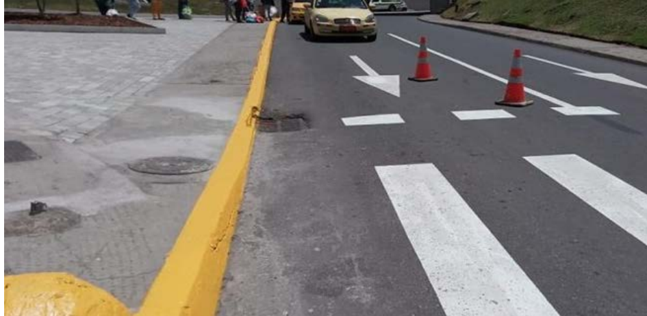
Figura 5. Bordillo señalizado. Fuente: (Quito informa, 2024)
