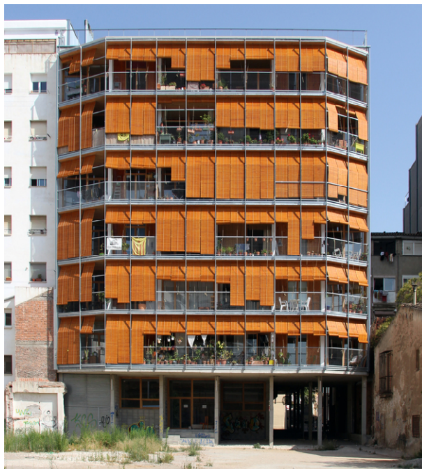
Figura 12. Edificio la Borda/Lacol – Cohousing (Barcelona, España, 2018).
