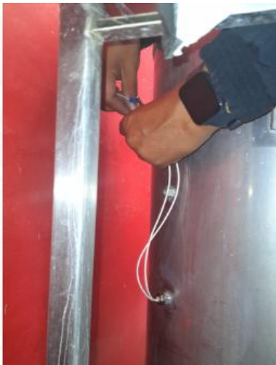
Figura 21 Instalación del sensor de temperatura Pt100
