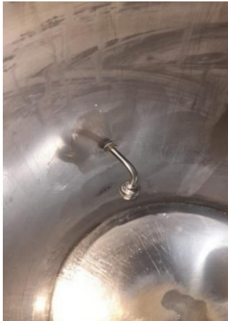
Figura 15 Colocación del sensor de nivel KeensoTbq
