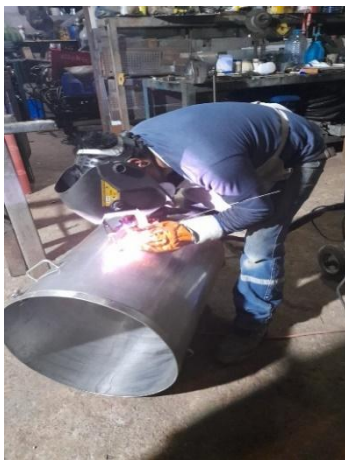
Figura 14 Soldadura de la rosca M10
