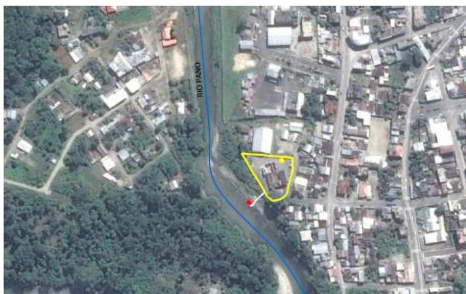
Imagen 1. Ubicación de la PTAR Palandacocha
