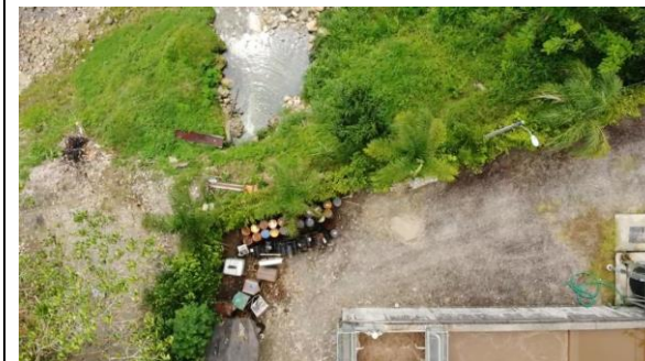
Punto de descarga del agua tratada de la PTAR Palandacocha
