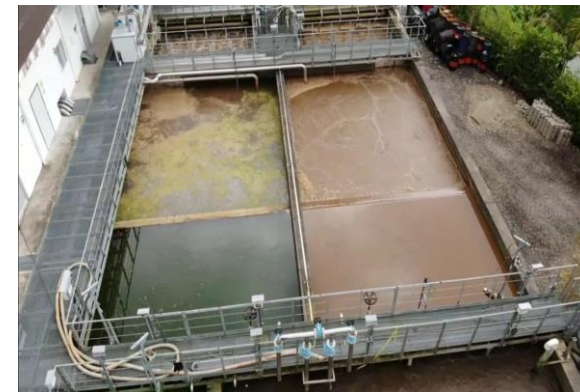
Tanque de aireación
