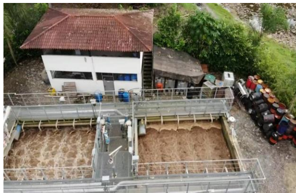
Tanque de Recepción de las aguas residuales
