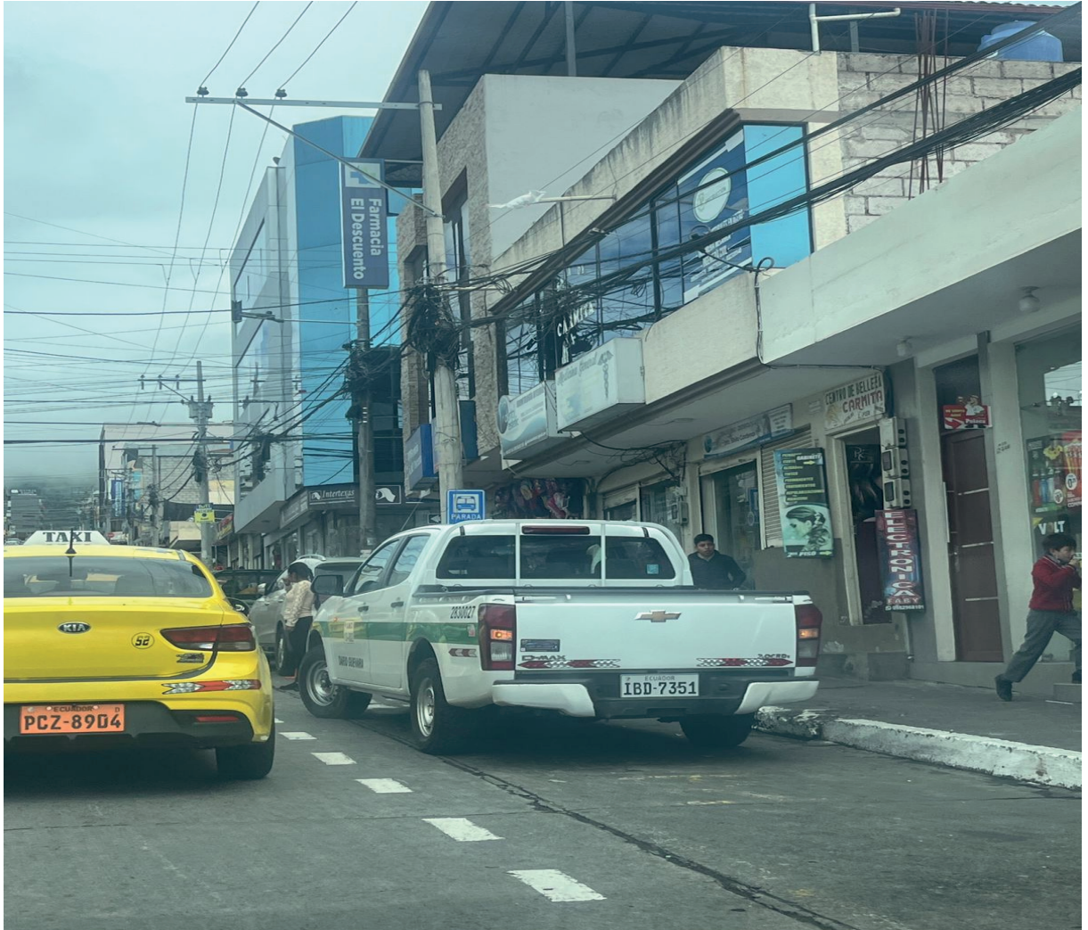
Figura 31. Vía Velasco Ibarra en mal estado - Antes
