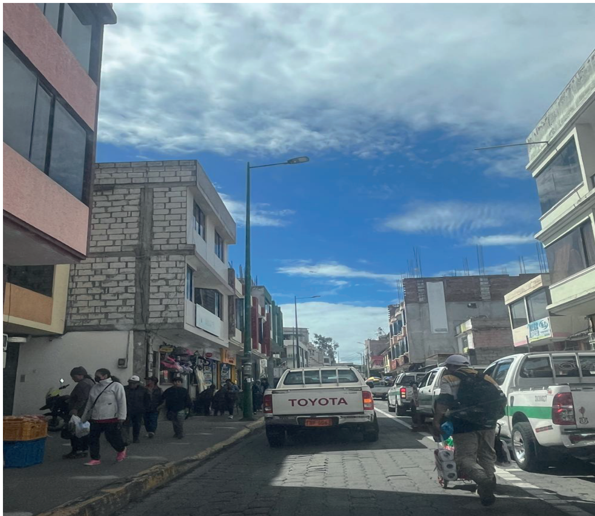
Figura 29. Vía Quis Quis en mal estado - Antes
