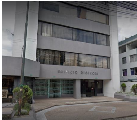
Figura 9. Infraestructura y Oficinas de OCA
