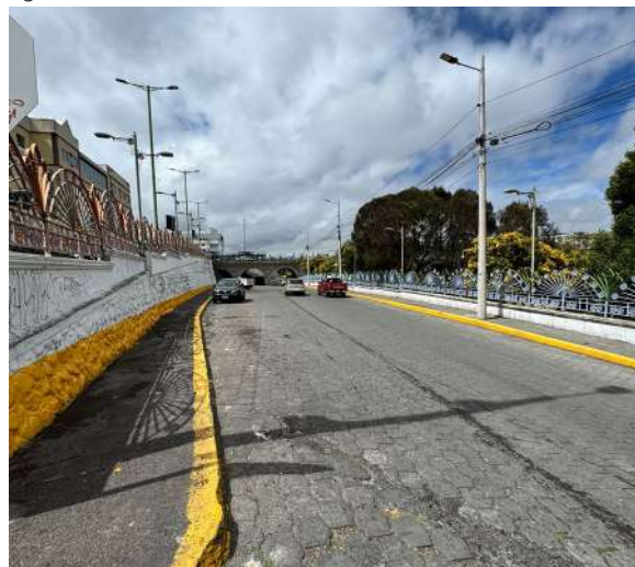
Figura 58. Estado actual de la intervención RED-01
