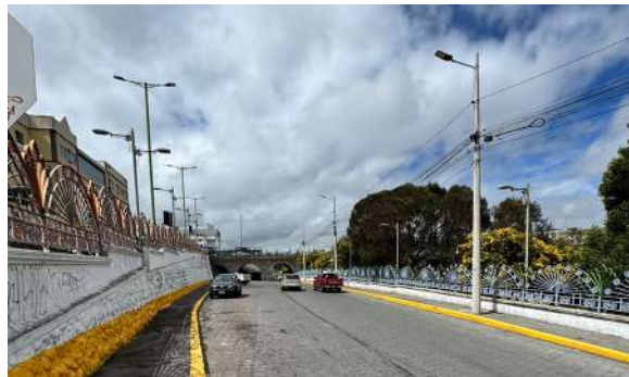
Figura 69. Estado actual de la intervención SU-O2
