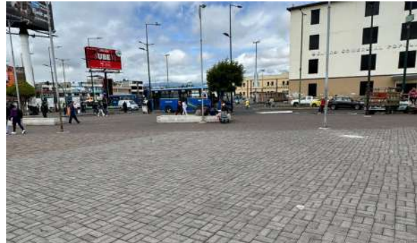
Figura 65. Estado Actual de la intervención IS-O2
