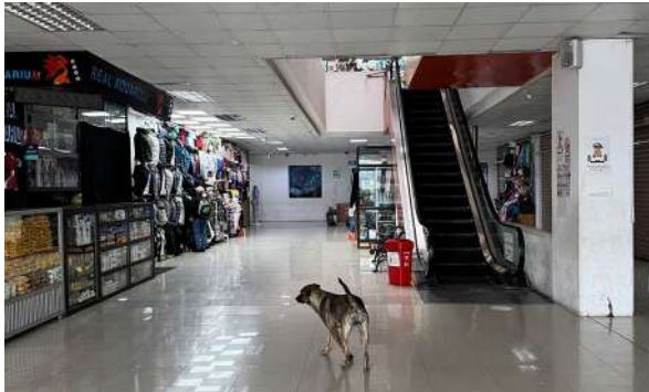
Figura 84. Estado Actual de la intervención SU-O3
