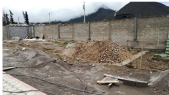
Figura 11: Material pétreo en obra.
