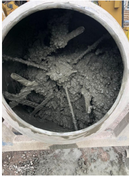
Figura 44: Uso de concreta para realizar hormigón.
