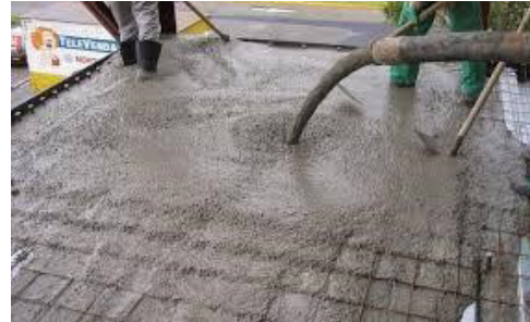
Figura 21: Hormigón en obra.
