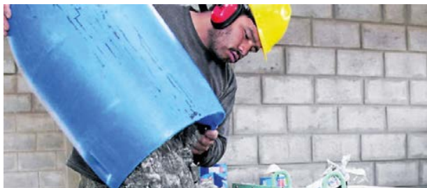
Figura 14. Elaboración de ladrillo de plástico. Fuente: Ecuaplástico 2021.
