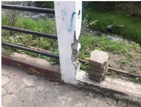
Foto 9: Infraestructura de cerramiento
