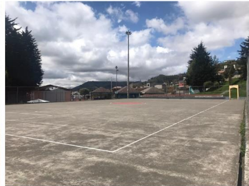
Foto 2: Cancha de futbol de cemento
