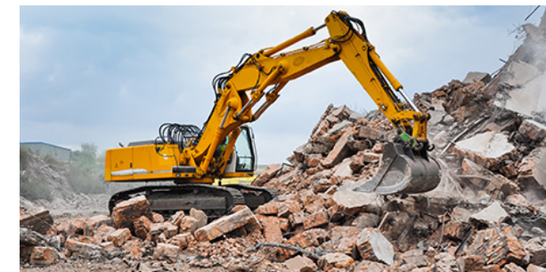
Figura 7. Materiales retirados de una edificación tras su demolición
