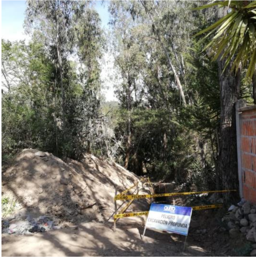
Gráfico 10 Excavación incompleta alcantarillado.
