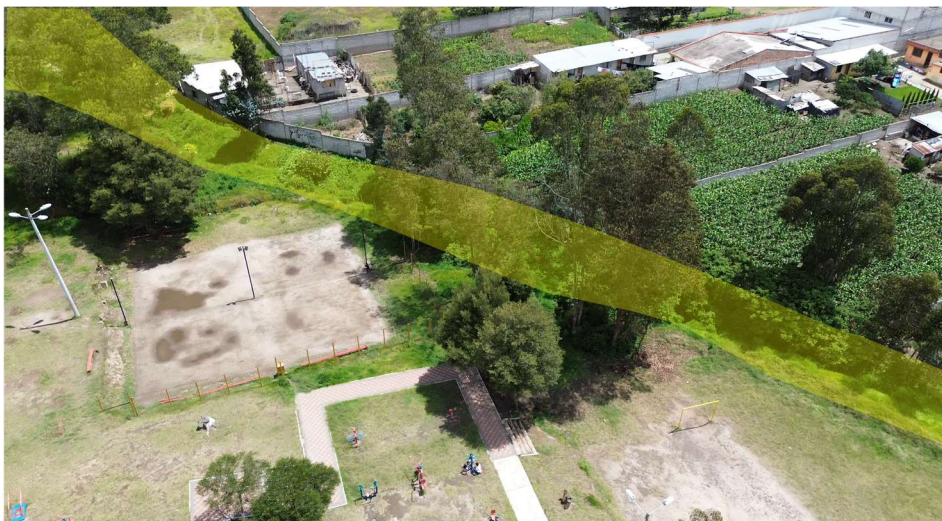
Imagen 41. Área recreativa infantil y quebrada rellena este.
