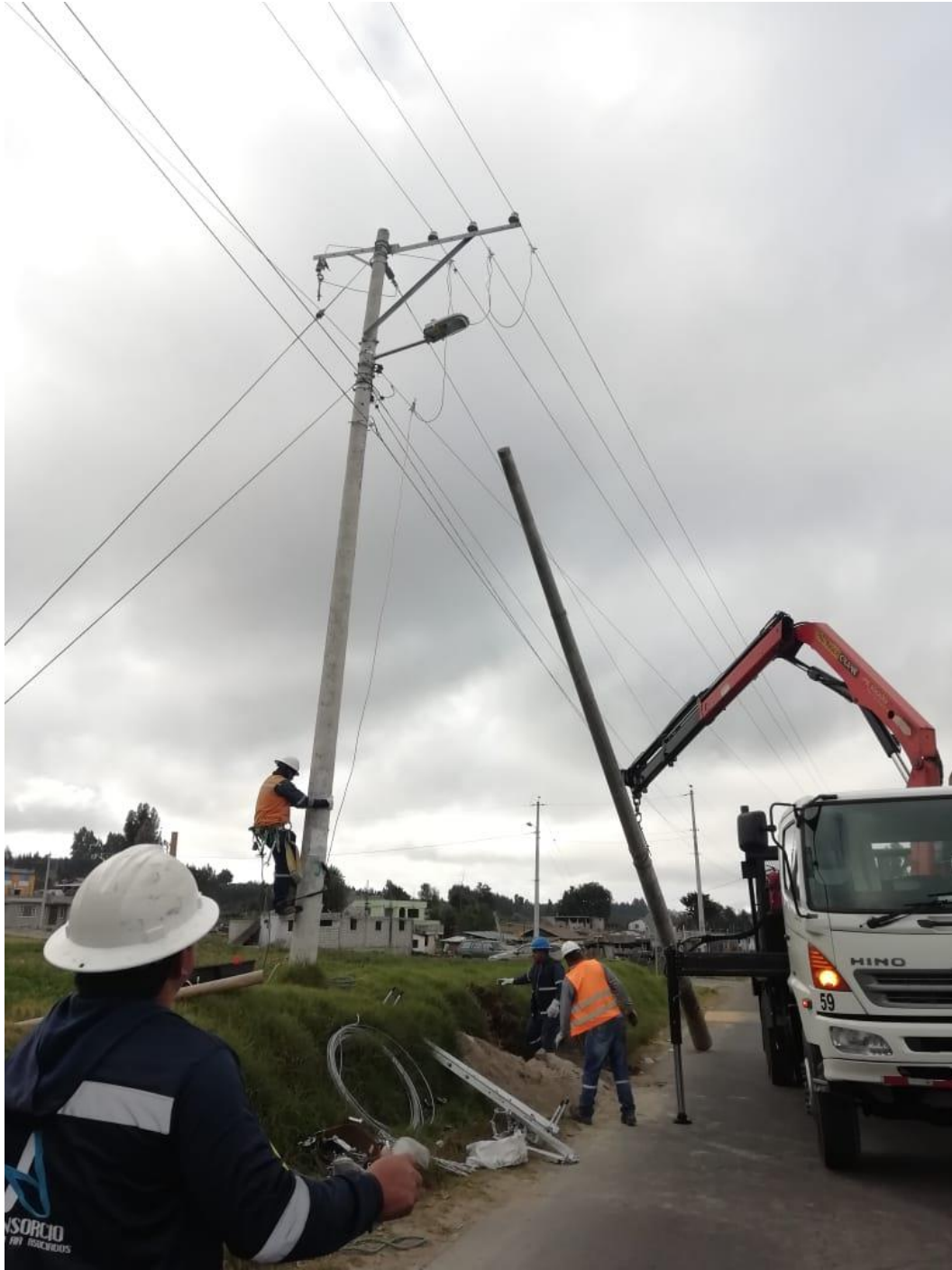
En la fotografía muestra el proceso de Instalación de materiales.
