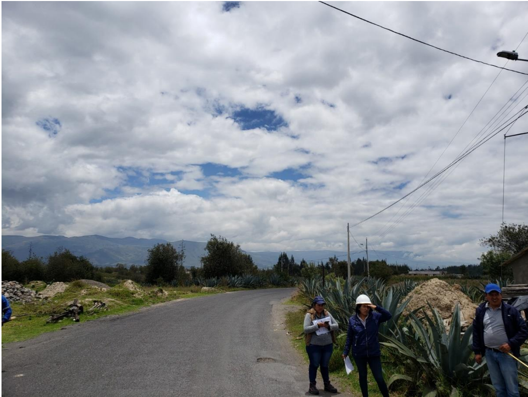
La fotografía muestra el proceso de Replanteo del proyecto.
