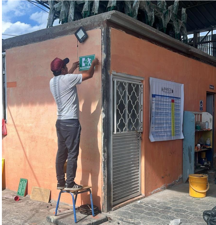
Colocación de señaléticas de emergencia
