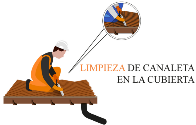
Gráfico 92: Limpieza de canaletas.
