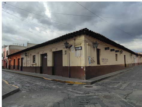
Imagen 50: Inmueble patrimonial tipo C.
