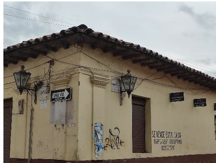
Imagen 26: vandalismo en inmueble patrimonial.
