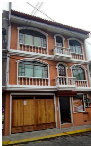
Imagen 52: Inmueble patrimonial tipo C.
