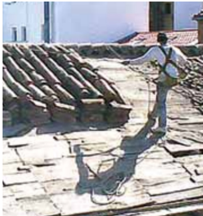
Imagen 31: Proceso de reparación en el centro histórico de Sucre.
