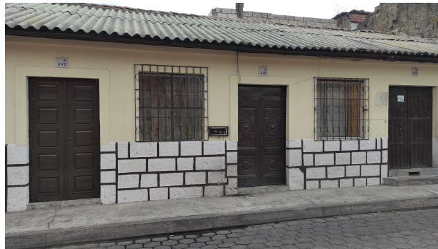
Imagen 51: Inmueble patrimonial tipo C.
