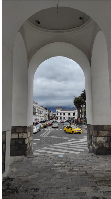
Imagen 55: Estructura de inmueble patrimonial.
