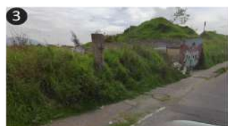
Aceras en mal estado
