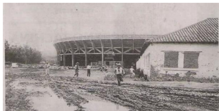
Gráfico 44 Plaza de toros de la Jipijapa en plena construcción en 1957.
