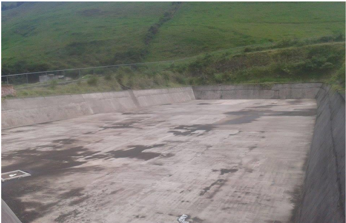
RESERVORIO DEL CANAL DE RIEGO PILLARO
