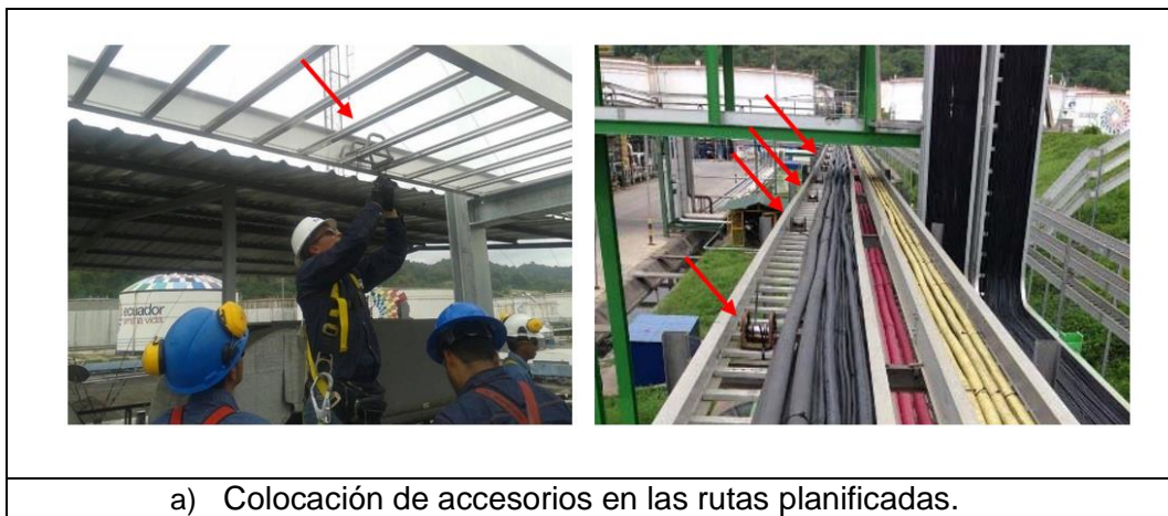
Colocación de accesorios
