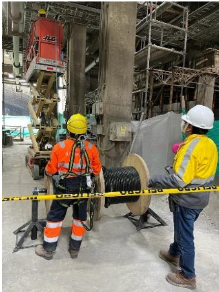
a) Instalación de desbobinador de cable y colocación de extrusadora.
