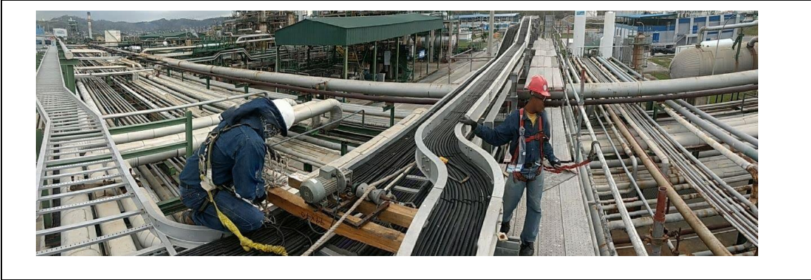
a) Instalación y energización de Puller en la ruta planificada.
