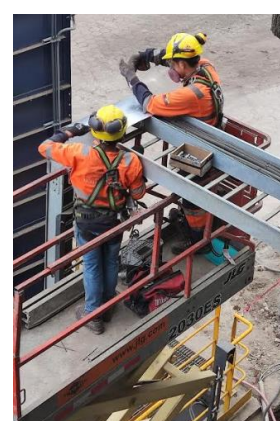
a) Colocación de tapas en bandejas portacables alrededor de todo el tramo planificado.
