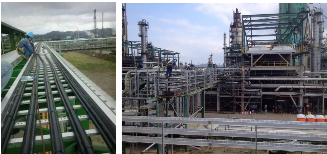
a) Tendido de conductor, peinado y amarrado en la ruta planificada.
