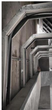
a) Colocación de tapas en bandejas portacables alrededor de todo el tramo planificado.
