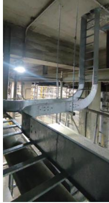
a) Instalación de bandeja hasta los gabinetes previstos.
