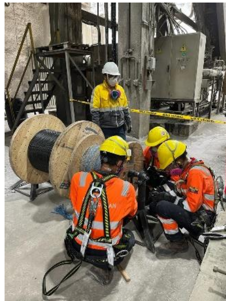
a) Instalación de desbobinador de cable y colocación de extrusadora.
