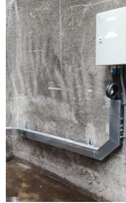
a) Instalación de bandeja hasta los gabinetes previstos.
