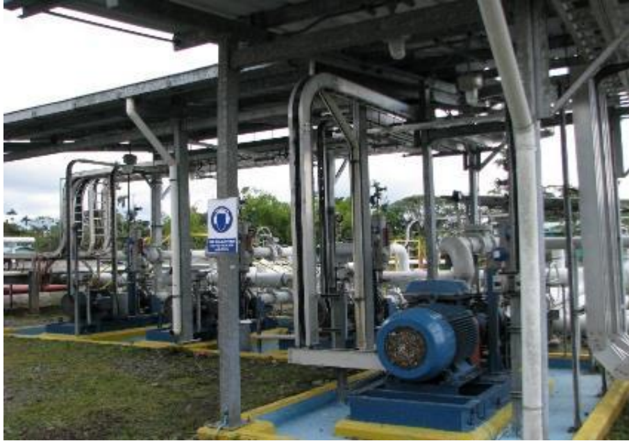
IMAGEN NO. 23: EQUIPOS OPERANDO EN CAMPO.
