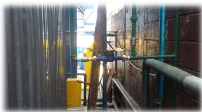
Gráfico 27: Instalación de medidor de caudal.
