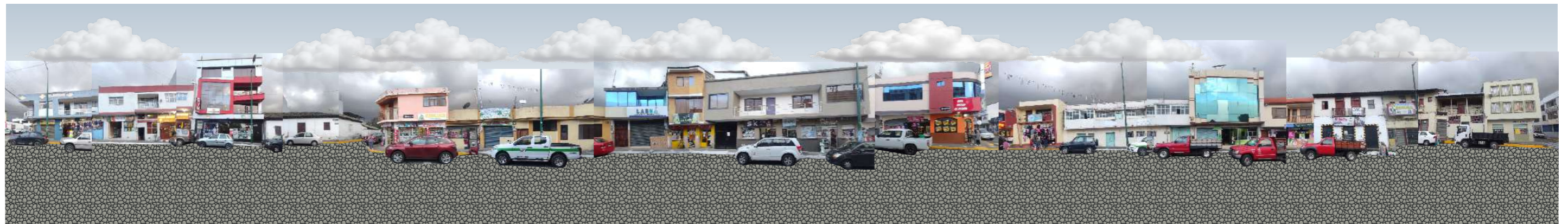
ESTADO ACTUAL TRAMO 2 VISTA OESTE
