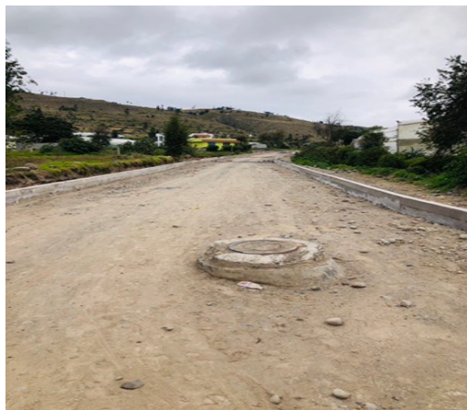
Imagen 5. Colocación de tubos de drenaje de cemento.
