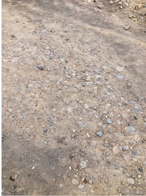
Imagen 7. Colocación de material “piedra”, primera capa.
