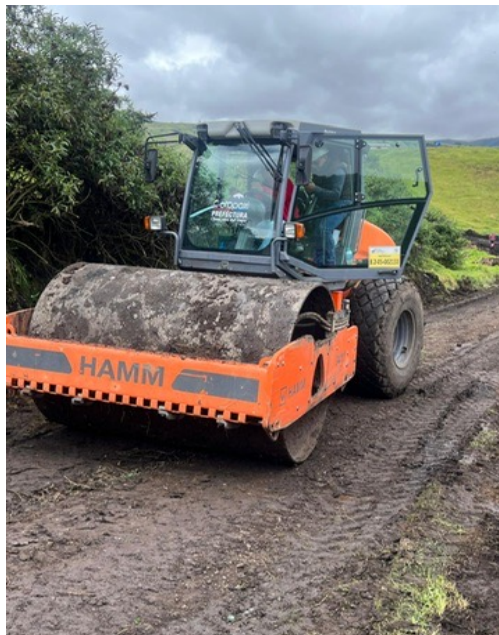
Imagen 8. Colocación de material “piedra”, primera capa.
